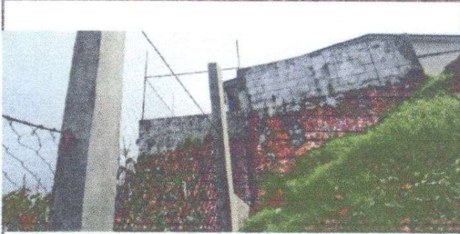
Foto 7: Muro perimetral finalizado con éxito, con materiales de block, postes de concreto y malla galvanizada.
