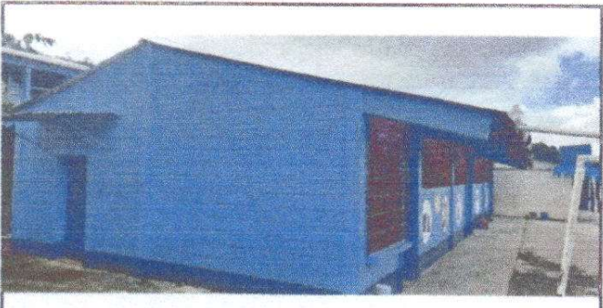
Foto 5: Edificio escolar cubierto por pintura nueva tanto interior y exterior.
