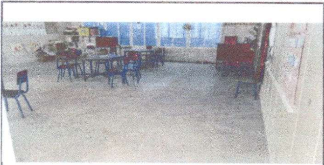
Foto 3: Torta de concreto colocada en el aula de preprimaria a cabalidad
