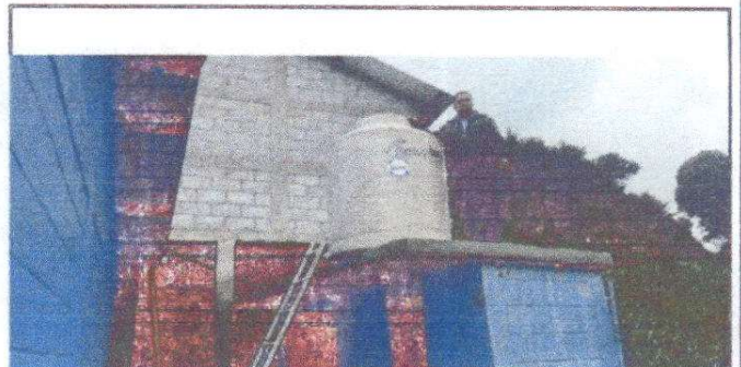
Foto 10: Depósito de agua colocado en el lugar correspondiente.
