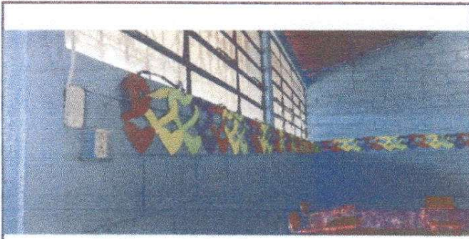
Foto 9: Mantenimiento y reparación de sistema eléctrico, finalizado con éxito.
