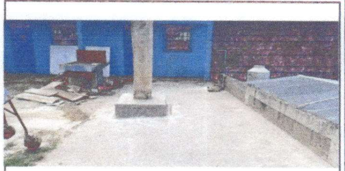
Foto 8: Patio de cocina reparada con planchas de concreto.
