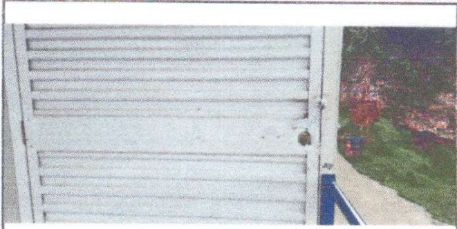
Foto1: Chapas instaladas al 100%
