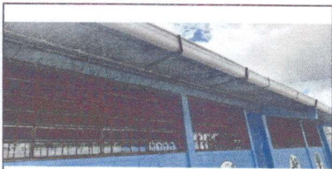
Foto 4: Canales y bajadas de agua sustituidos por nuevos.
