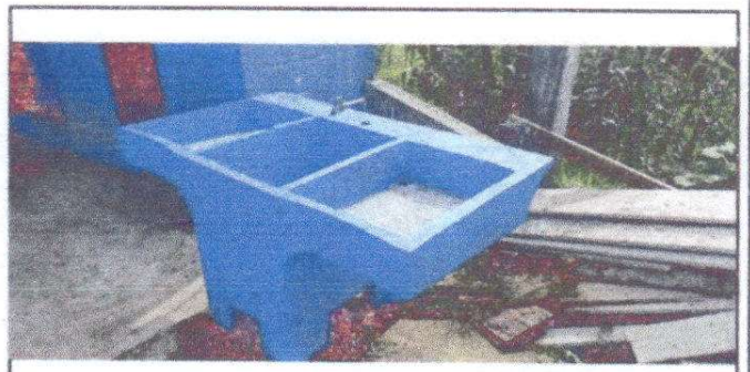
Foto 12: Pila de cemento de dos lavaderos colocada en el lugar correspondiente.
